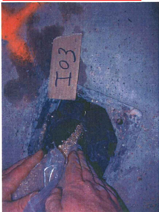
Photos 1 à 3 : Vue de la mise en place du graviers
