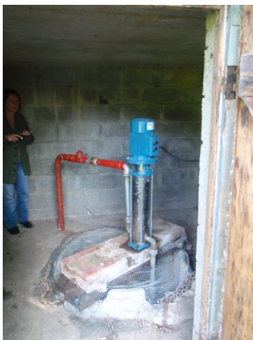
Intérieur du captage : sommet du puits et pompe ; un grillage recouvre le puits
