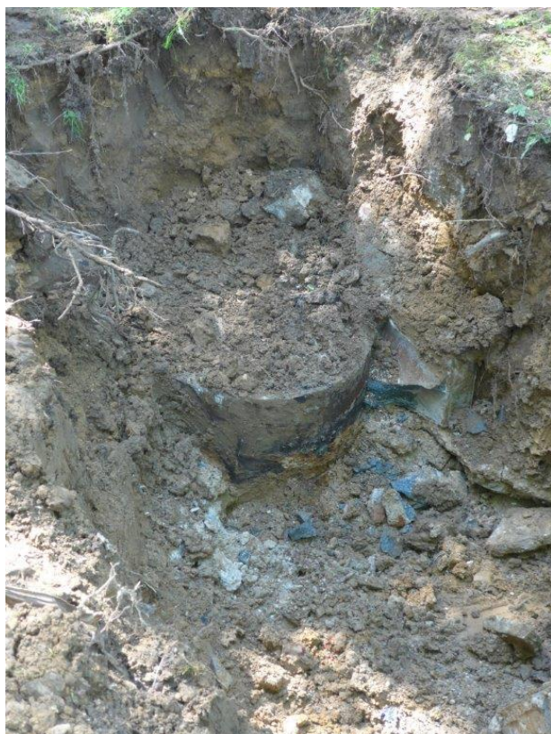
Tubage acier du forage rebouché
