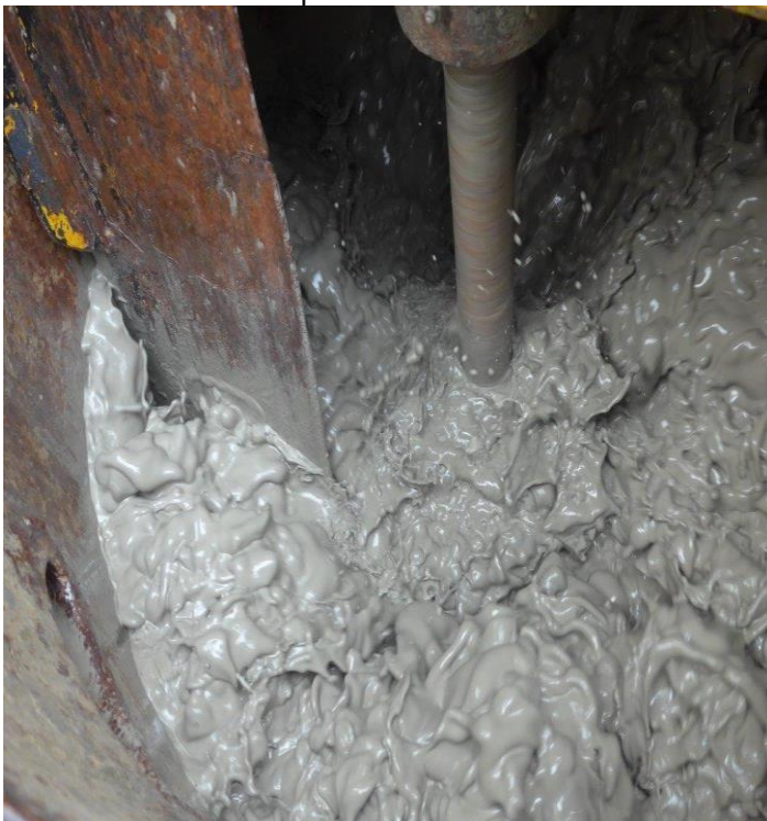
Préparation et malaxage du laitier
