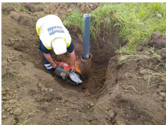
Sciage du tube acier
