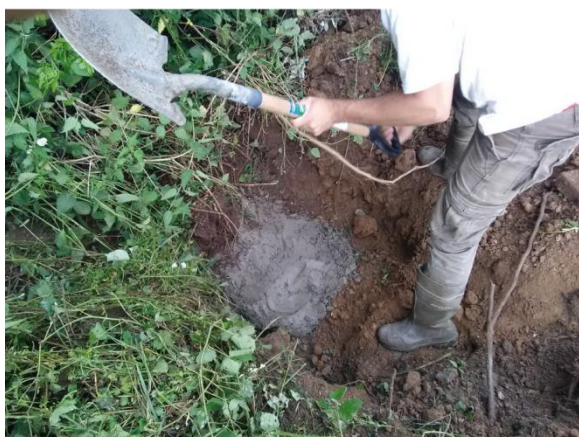
Bouchon de béton au sommet des ouvrages
