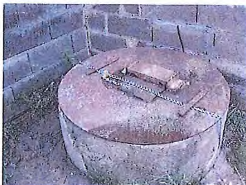
La buse est recouverte par une plaque d'obstruction, hermétique, fermée par cadenas.
