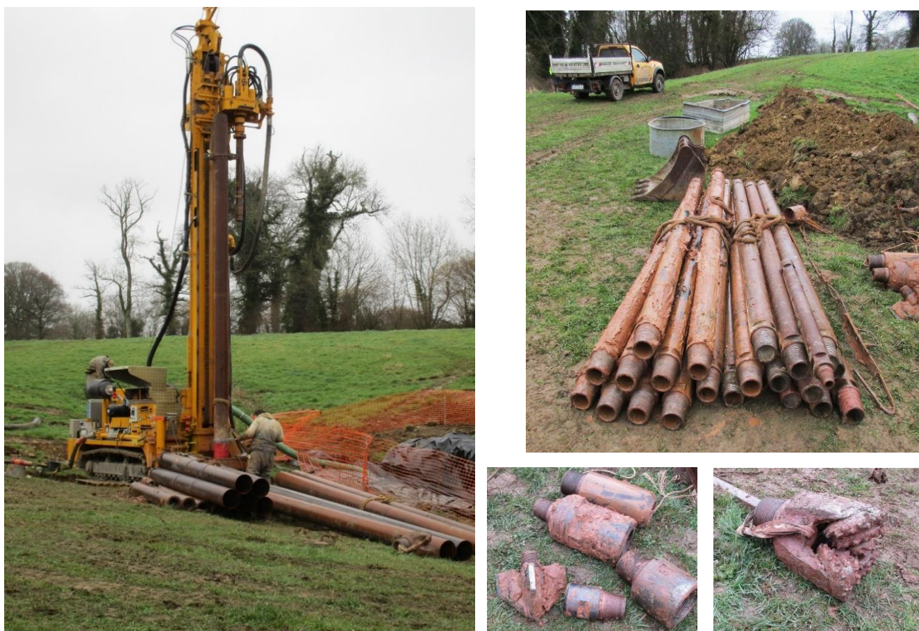
Figure 7 : Photographies de l'atelier de forage F1, implantation tubage acier, train de tige et outils de foration utilisés
