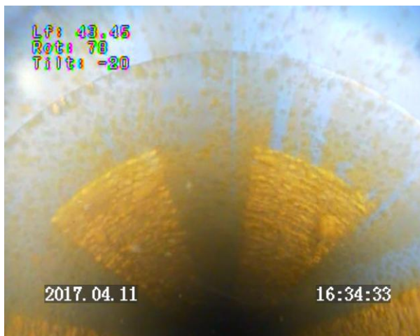
Prof 43.45 m : vue axiale sur les premières crépines / floccs ferro-bactériens sur les fentes des crépines
