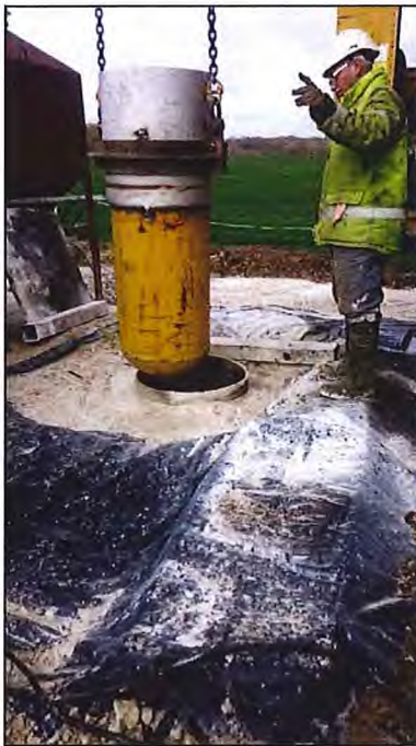
Photo 3: Tube et sabot de cimentation
