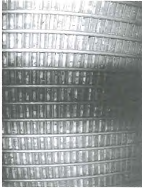
8- Tubage inox crépiné (-32.8 m) – les fentes sont ouvertes, observation du massif filtrant
