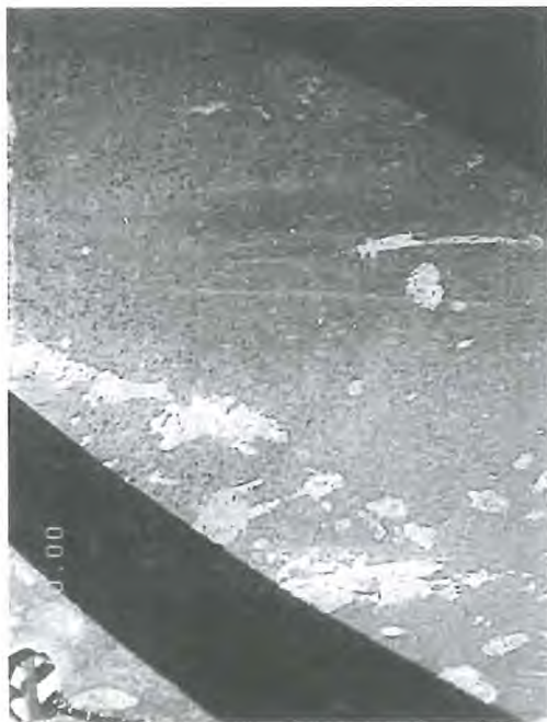
1- Sommet du tubage acier – la paroi est légèrement oxydée, trou de manoeuvre
