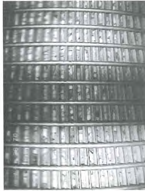
10- Tubage inox crépiné (-36.7 m) – légers dépôts au droit des fentes
