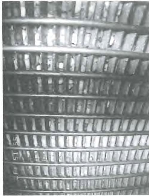
14- Tubage inox crépiné (-51.65 m) – les fentes sont ouvertes, dépôts au droit des fentes
