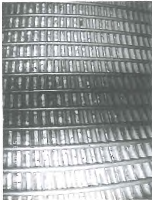
13- Tubage inox crépiné (-48.35 m) – très légers dépôts au droit des ouvertures
