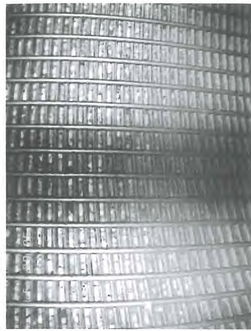
11- Tubage inox crépiné (-39.35 m) – les fentes sont ouvertes, dépôts au droit des fentes
