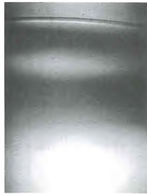
12- Tubage inox plein (-43.5 m) – la paroi de la colonne captante est en bon état
