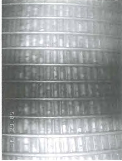
7- Tubage inox crépiné (-29.85 m) – fentes à fils enroulés, observation du massif filtrant
