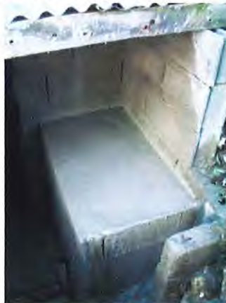
Photo de la tête de puits après comblement
