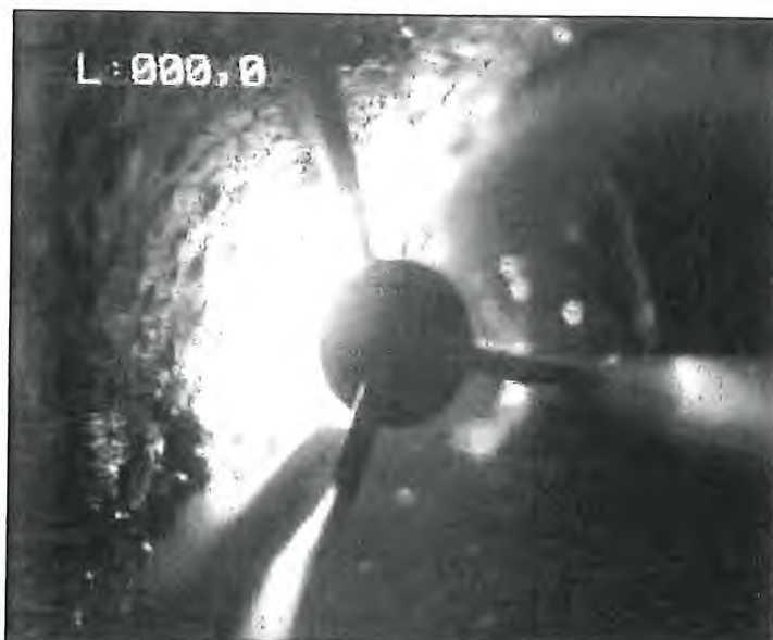
Figure 5 : Niveau statique : -3,40 m/sol avec une vue sur la corrosion de l'acier
