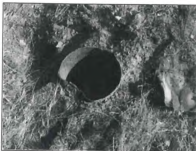
Figure 5 : Niveau statique : -3,40 m/sol avec une vue sur la corrosion de l'acier
