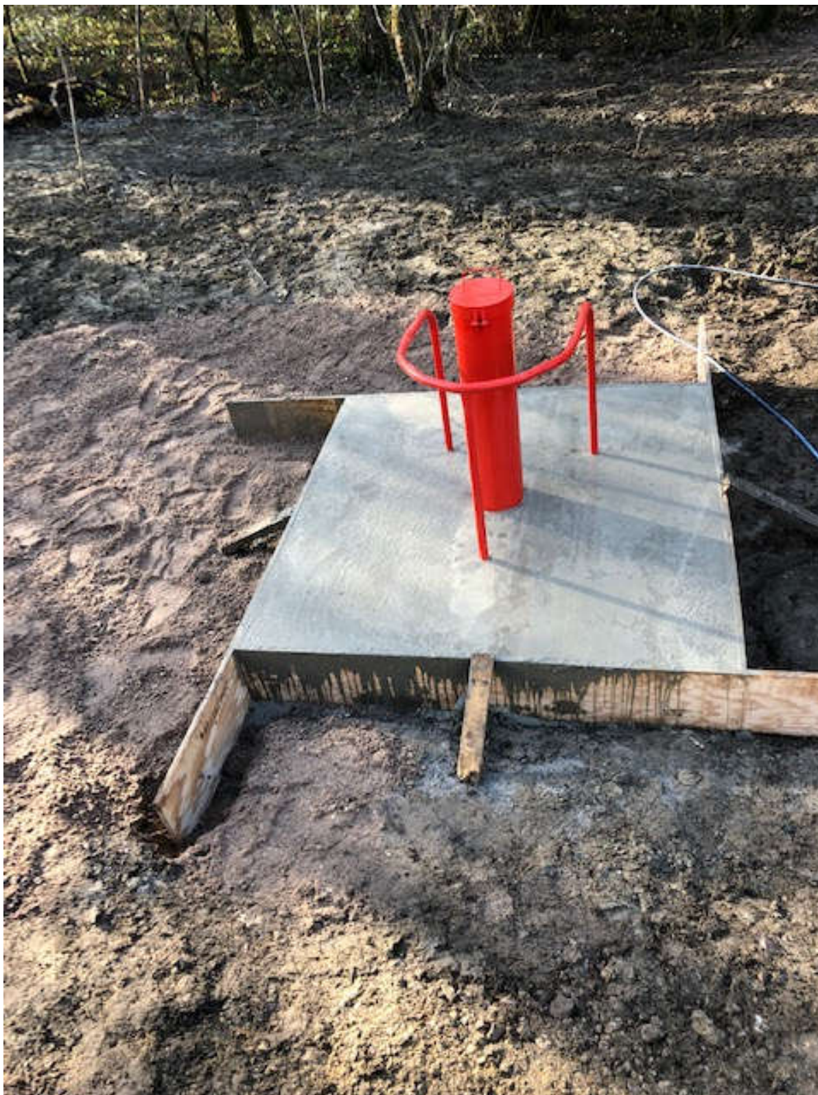
Vue du nouveau piézomètre "BRGM" de Dombrot-le-Sec (88) : superficie de 3m 2 , tête en acier cadénassé ; rambarde acier de protection.
