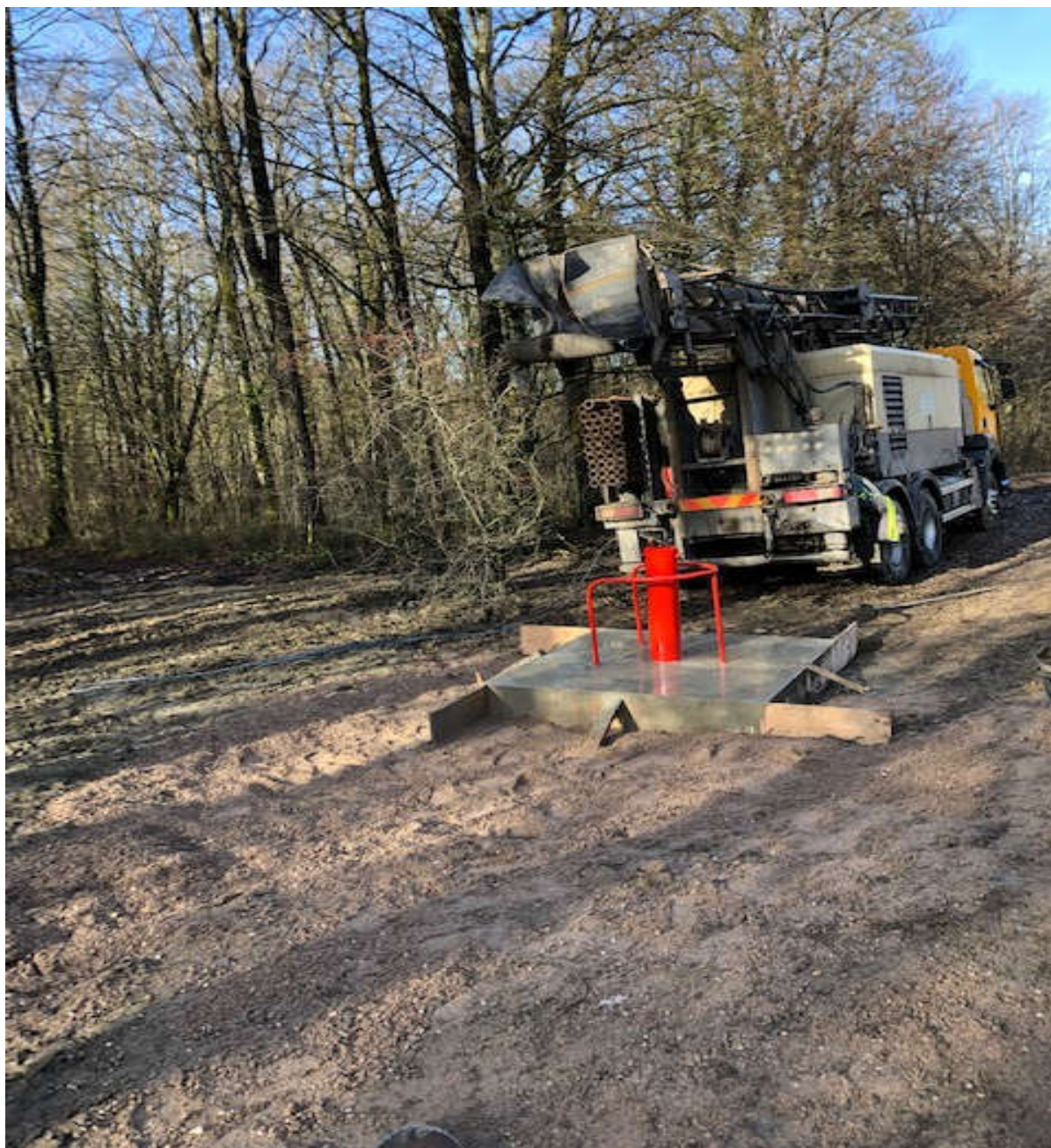
Vue du nouveau piézomètre "BRGM" de Dombrot : superficie de 3m 2 , tête en acier cadenassé ; rambarde acier de protection
