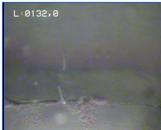
Vue sur un joint non étanche, bulles
