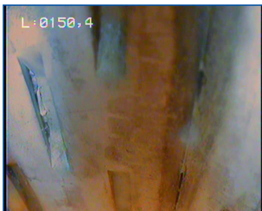
Nervures repoussées, massif filtrant visible
