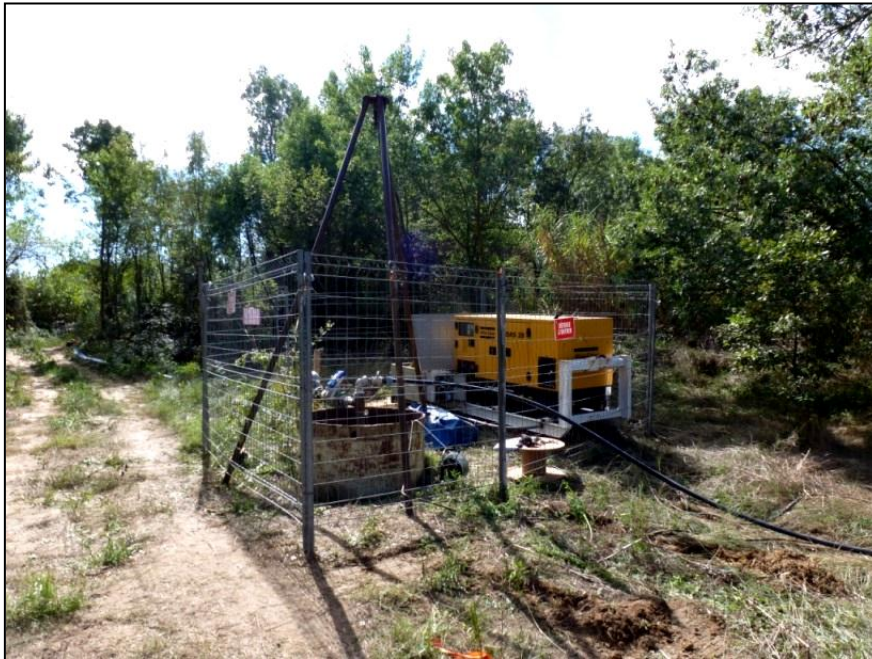
Vue des installations de pompage mises en place sur le puits des Mattes
