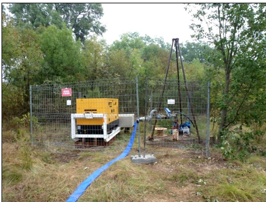
Vue des installations de pompage sur le forage des Mattes
