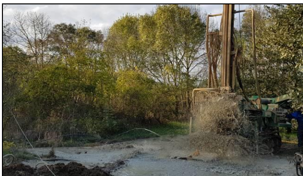
Vue de l'air-lift le 07/11/2018 (à gauche) et de la mise en place du tubage PVC Ø 112/125 mm le 08/11/2018 (à droite)
