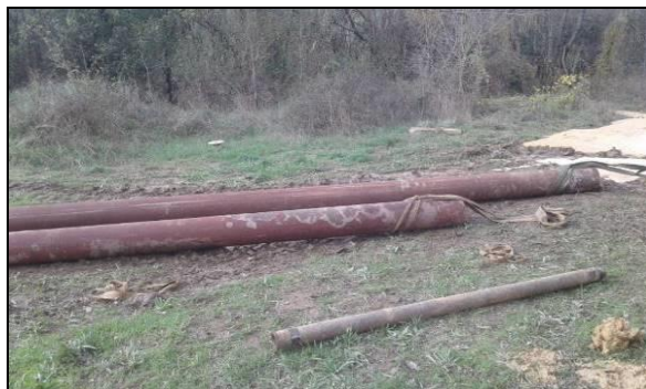
Vue de la foreuse le 30/10/2018 (à gauche) et du prétubage acier Ø 236,5/244,5 mm le 06/11/2018 (à droite)
