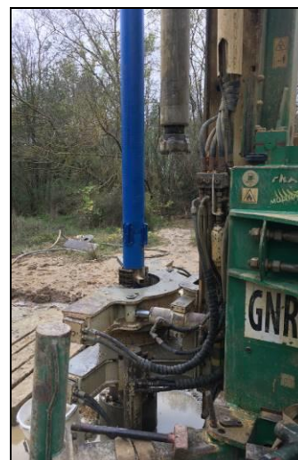
Vue de l'air-lift le 07/11/2018 (à gauche) et de la mise en place du tubage PVC Ø 112/125 mm le 08/11/2018 (à droite)
