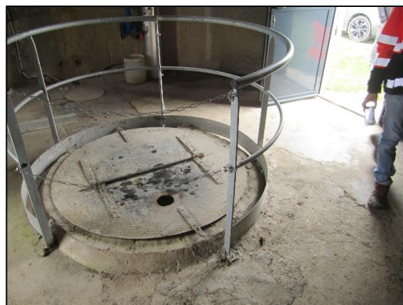
Puits béton diamètre 1,23 m (Au centre du château d'eau)
