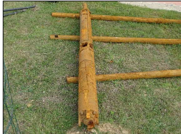
Colonnes découpées et pompes prêtes à être évacuées
