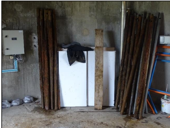
Colonnes découpées et pompes prêtes à être évacuées
