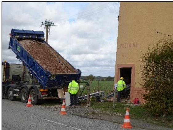
Livraison et mise en place gravitaire des graviers et du sablon (bande transporteuse)
