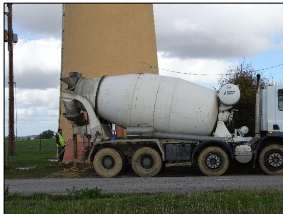
Livraison et mise en place du coulis de ciment
