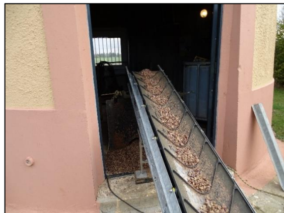
Livraison et mise en place gravitaire des graviers et du sablon (bande transporteuse)
