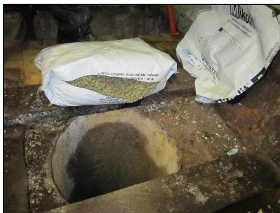
Mise en place des argiles (sacs de 25 Kg)
