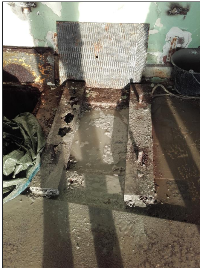
Rendu après comblement sur le forage Sud (cimentation remontée en surface)
