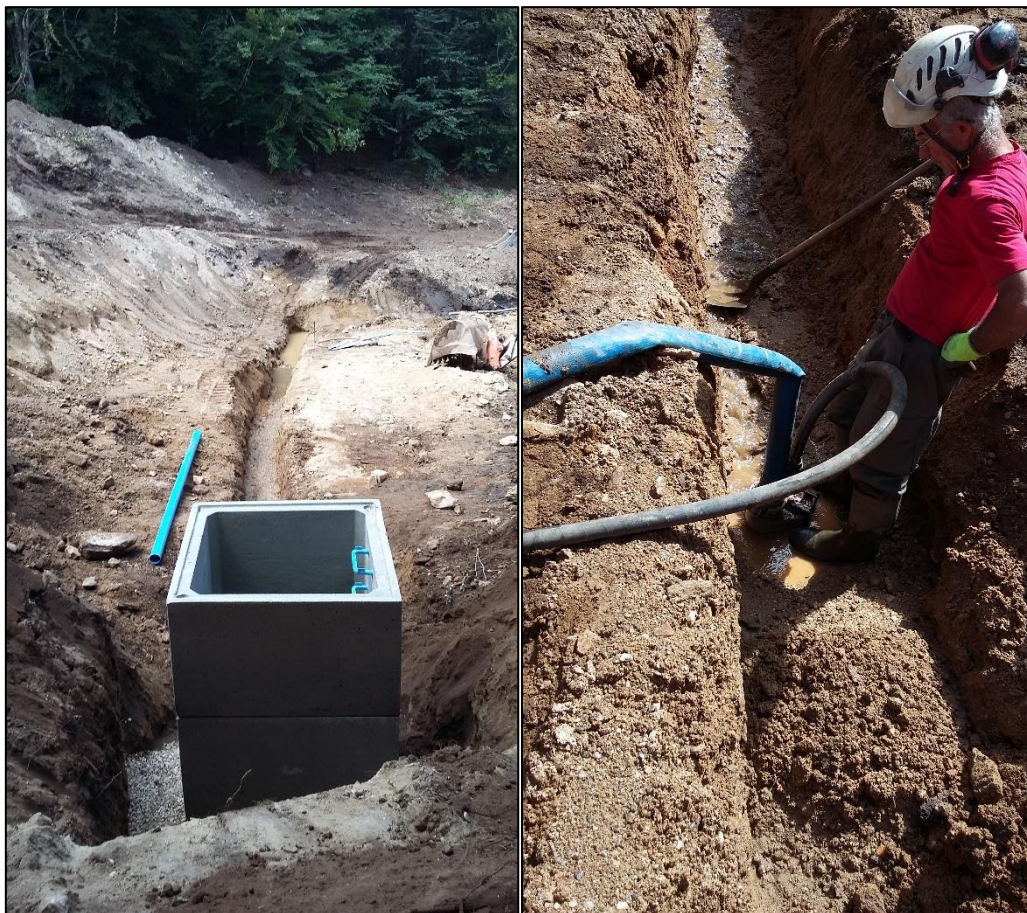
Approfondissement de la tranchée drainante (gauche) – Venues d'eau dans la tranchée drainante (droite)
