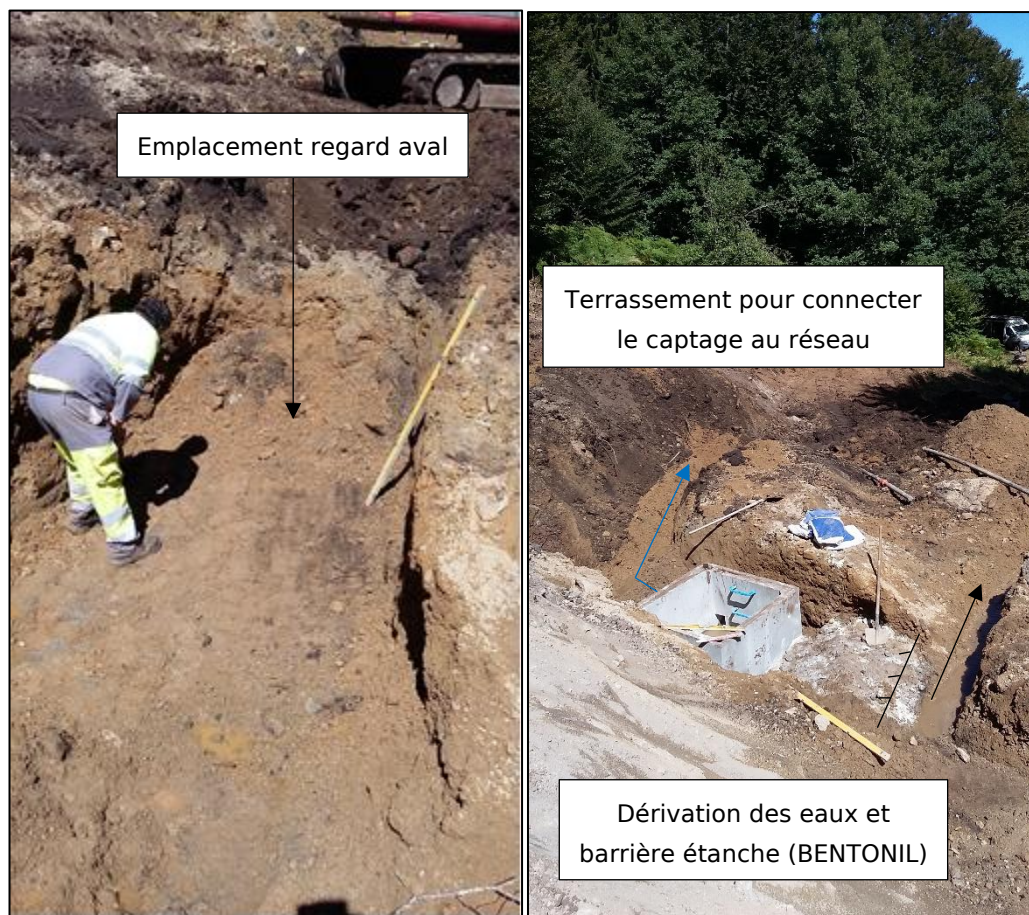
Emplacement du regard aval (gauche) - Vue du système de dérivation des eaux (droite)
