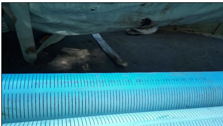
Vue et référence des canalisations crépinées posées dans la tranchée
