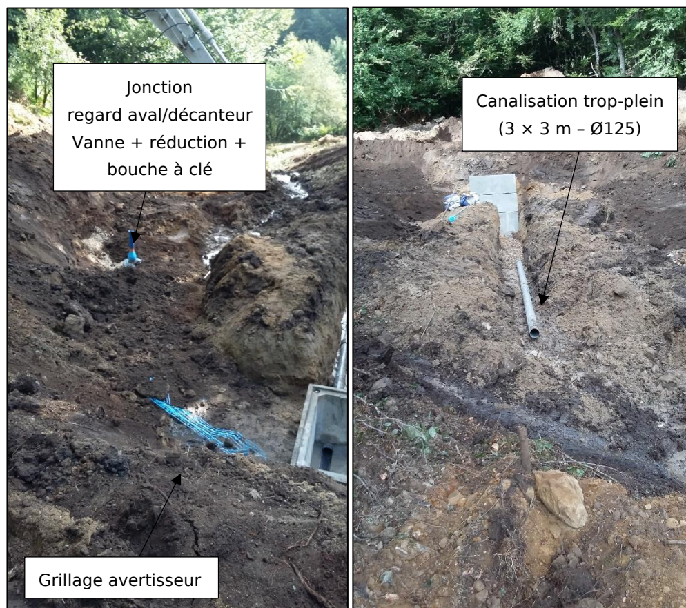
Vue du regard aval – connexion réseau et trop-plein
