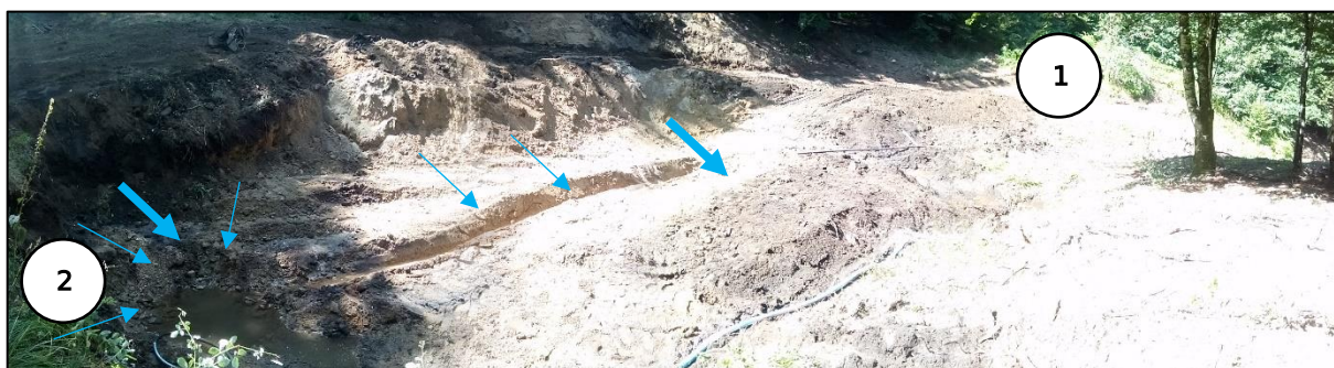
Vue de la tranchée drainante peu profonde et des venues d'eau
