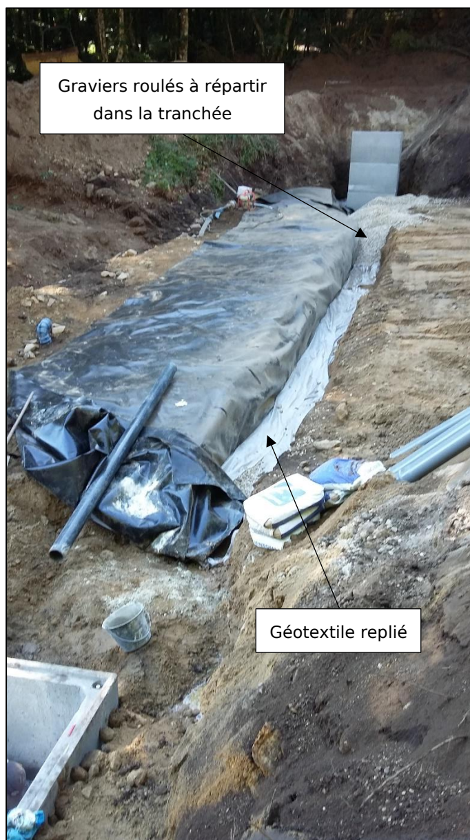
Vue de la tranchée drainante, géotextile et géomembrane partiellement comblée
