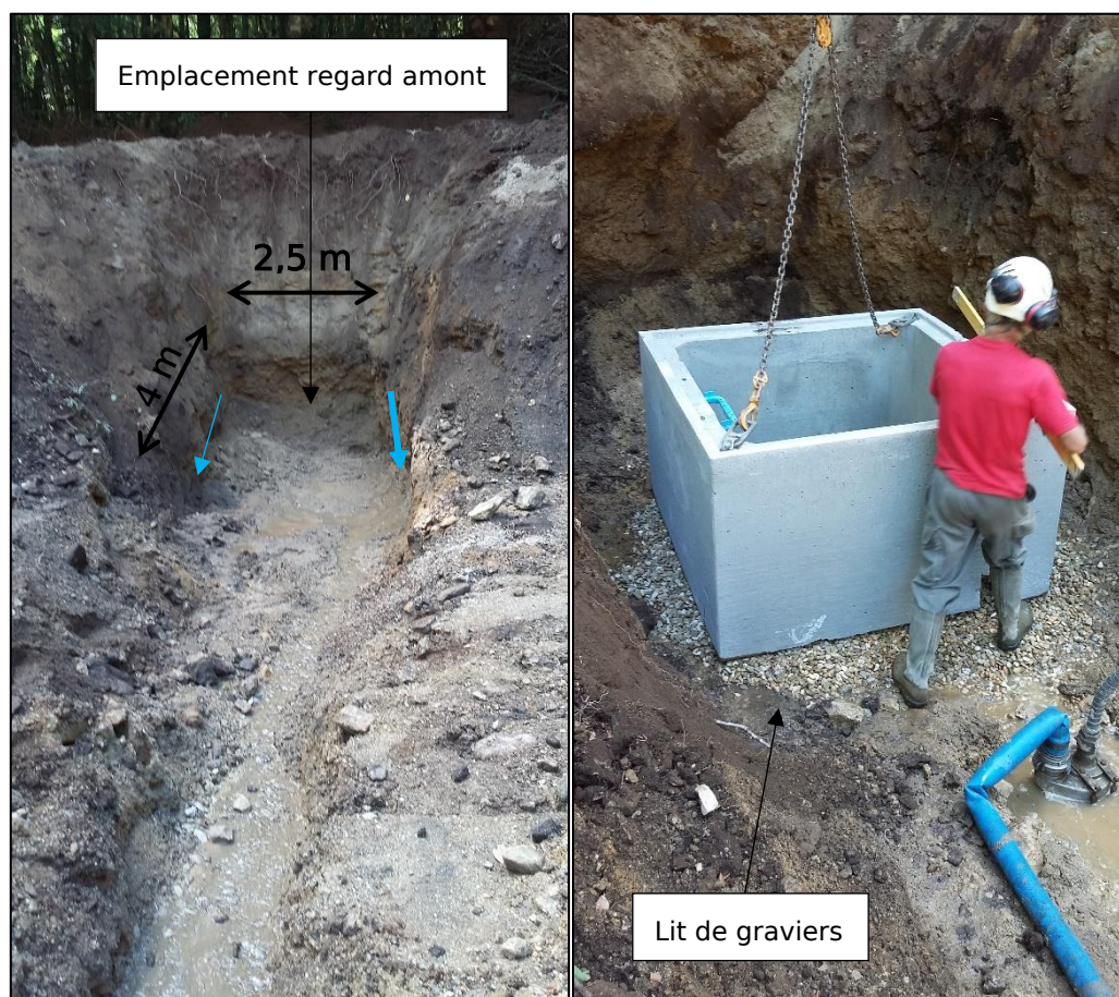
Vue de l'emplacement du regard amont et des venues d'eau (gauche) - Pose du premier élément du regard amont (droite)
