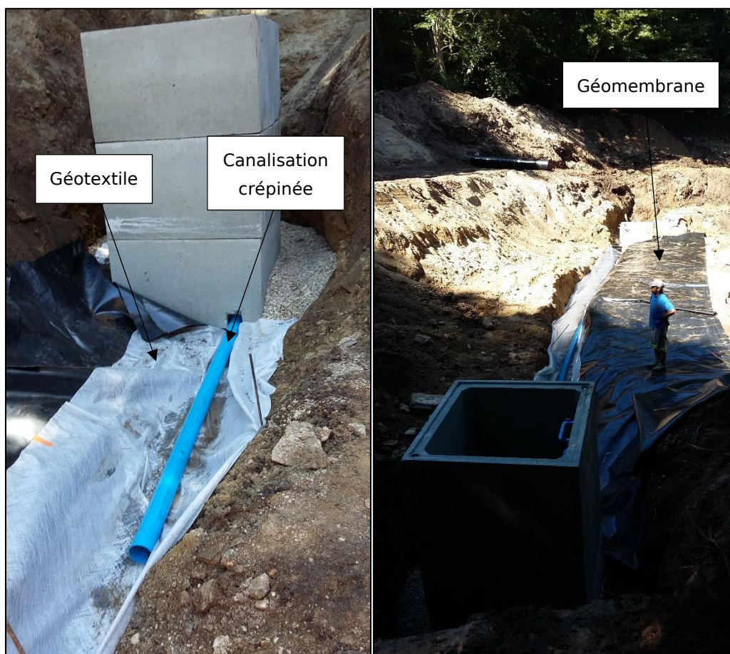
Vue des canalisations crépinées posées sur géotextile et géomembrane
