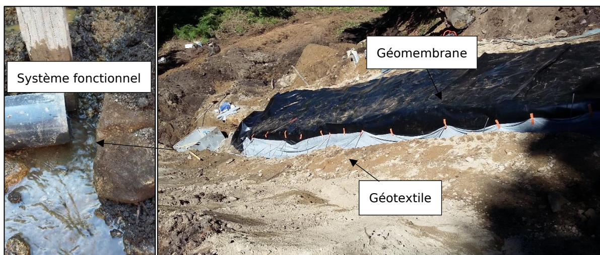
Vue du système de captage - tranchée drainante, géotextile et géomembrane
