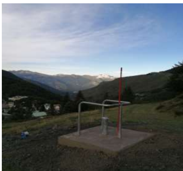
Protection de tête du PZ3 : capot hors sol galvanisé et cadénassé, avec dalle de 2 m 2
