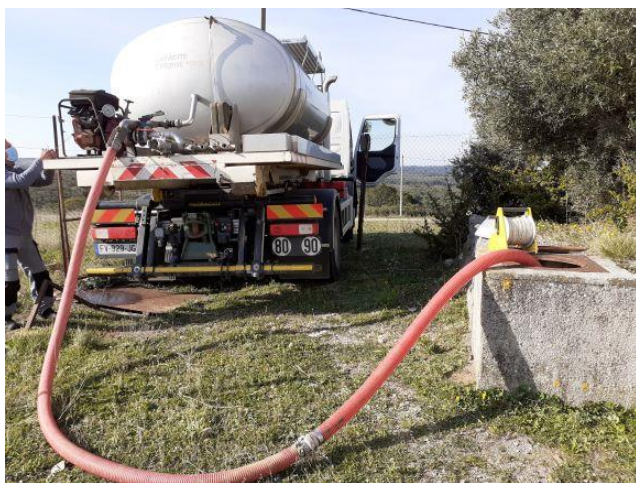
Figure 1: installation du camion et du tuyau d'injection dans l'ouvrage
