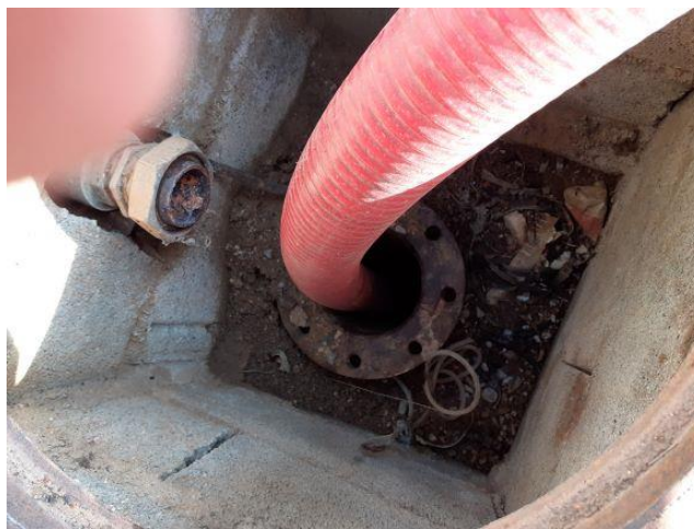
Figure 2: Tuyau dans l'ouvrage pour l'injection
