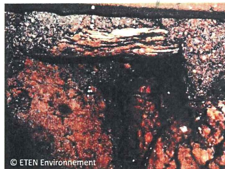
Vues de l'arrivée d'eau n°3 au niveau d'une jonction entre deux buses (à gauche) et des racines entre les fractures (à droite)
