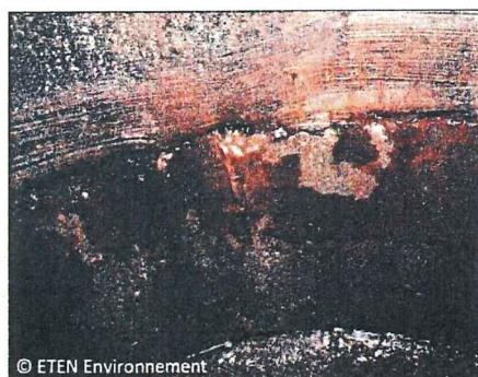
Vues de l'arrivée d'eau n°3 au niveau d'une jonction entre deux buses (à gauche) et des racines entre les fractures (à droite)
