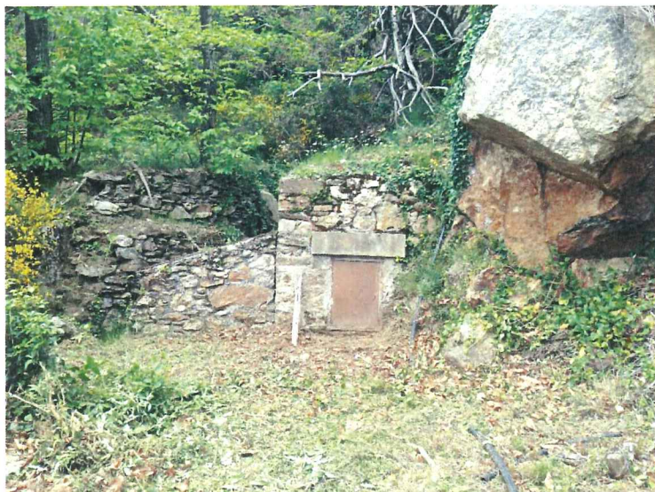
Bâti de captage adossé à l'affleurement gneissique fracturé
