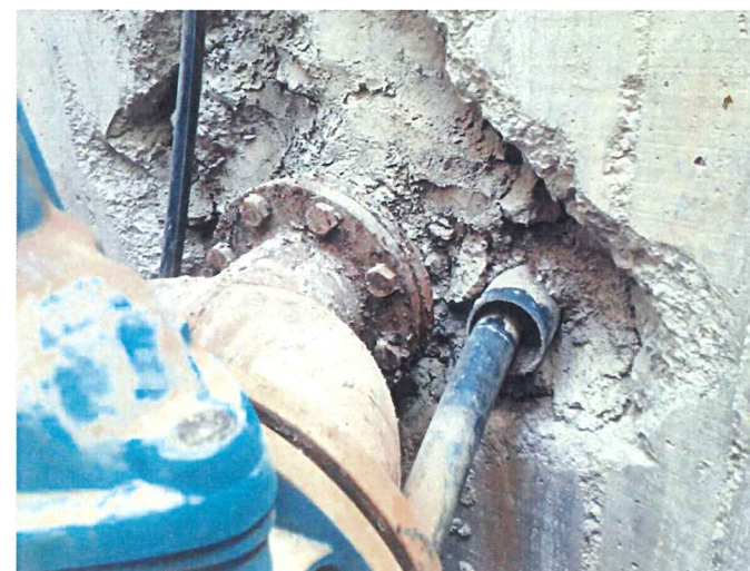
Défauts d'étanchéité des passages de câble et canalisation dans la paroi du cuvelage
