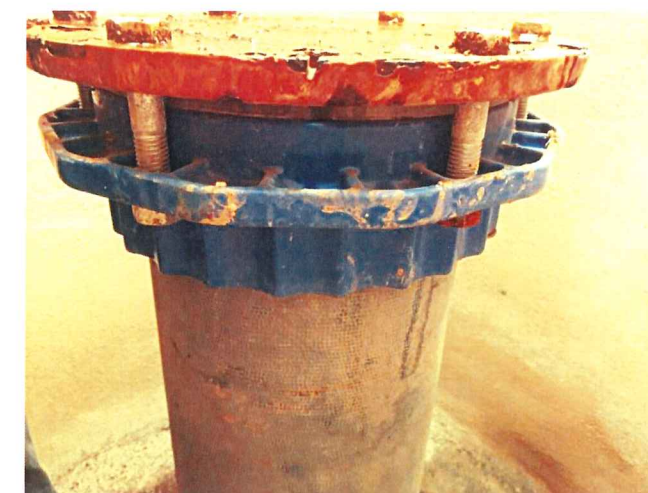
Capot de protection de la tête des piézomètres (ici le piézomètre Pz4)
