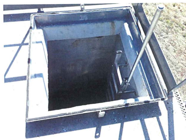
Capot de fermeture de l'accès à l'abri du Forage F3-1987 avec joint d'étanchéité dégradé
