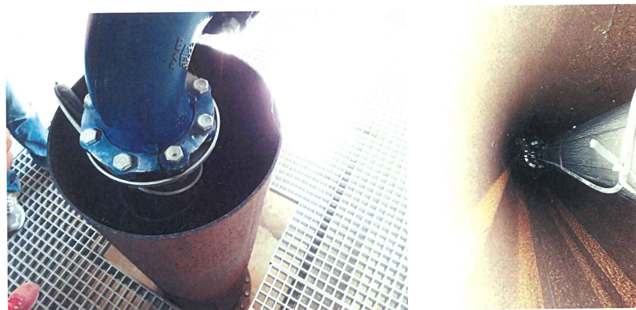
Tête de tubage acier sans protection anti intrusion et intérieur du tubage avec équipement en acier inoxydable
