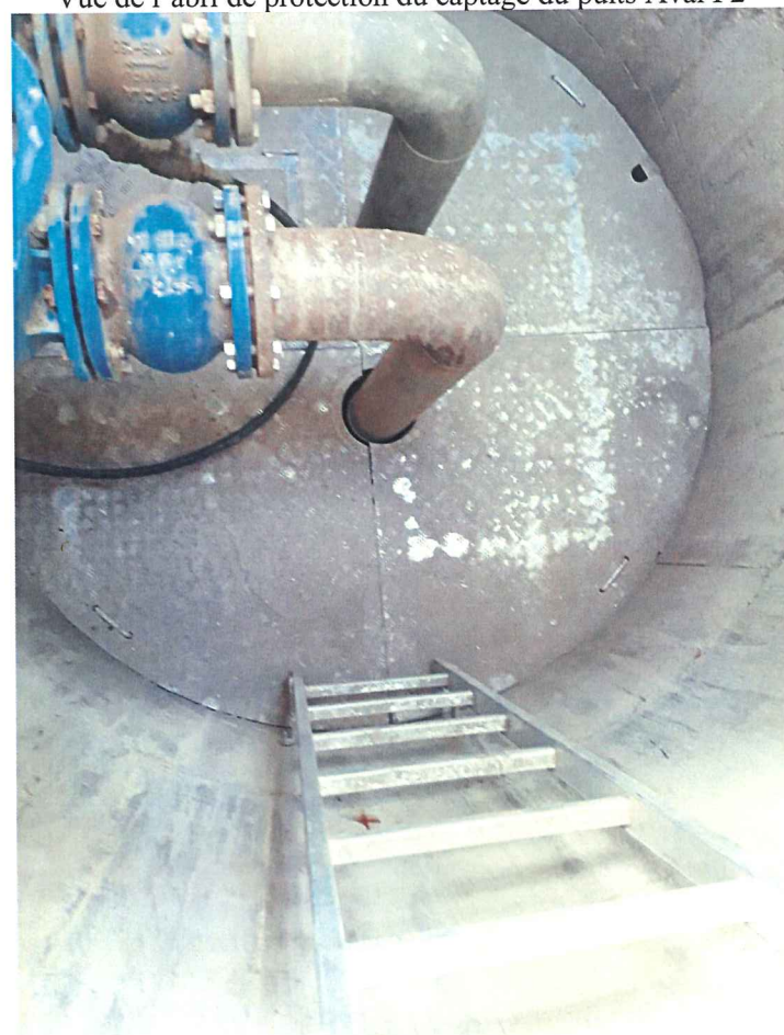
Présence de limons et sables fins sur les équipements intérieurs du puits Aval P2
