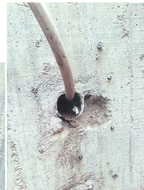
Défauts d'étanchéité des passages de câble et canalisation dans la paroi du cuvelage
