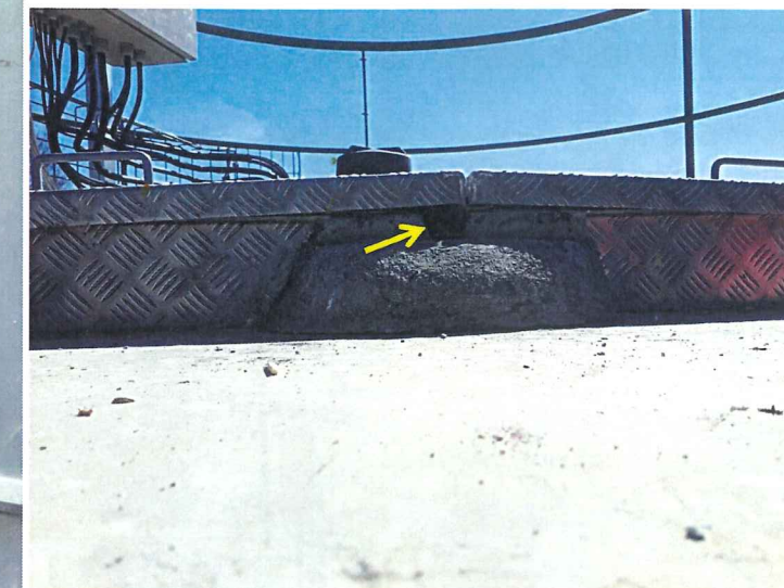
Défaut d'étanchéité du Puits Amont P1
