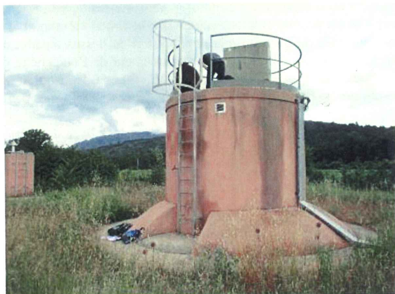
Vue de l'abri de protection du captage du puits Aval P2
