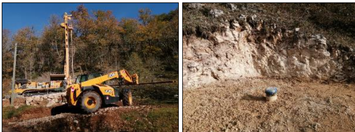
Photographie 3 : Vues de la foreuse au droit de F3 et de la tête de F3 (Clichés Calligée, 17/11/2020 et 24/11/2020)
