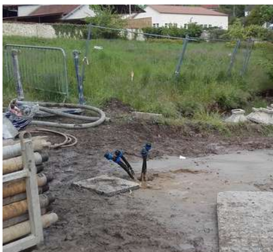
Sonde géothermique verticale à tester
