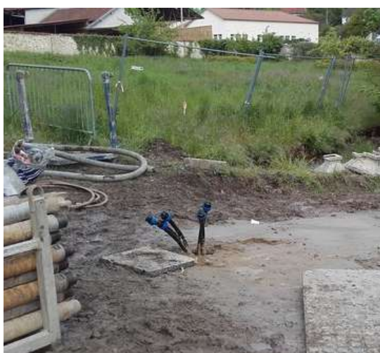
Sonde géothermique verticale à tester
