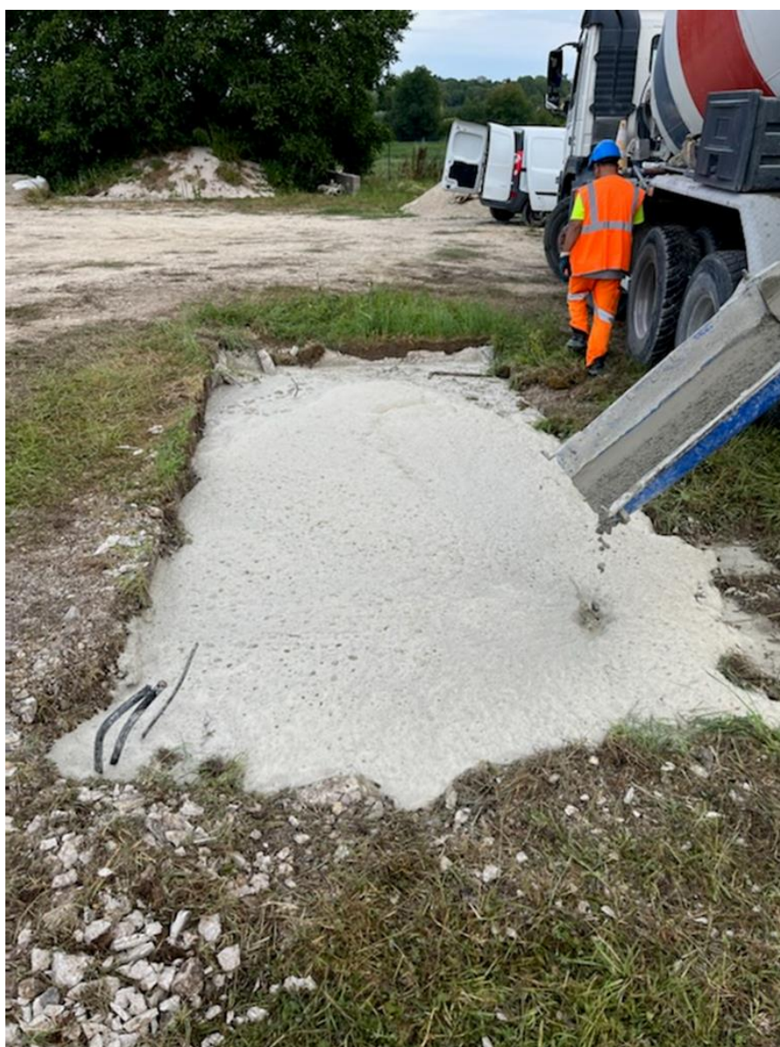
Figure 2/ Forage MARGAT 3 après obturation
