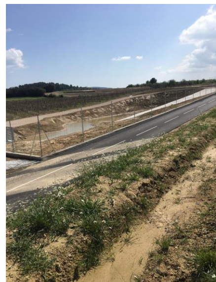
Bassins de rétention/infiltration sur la D5
