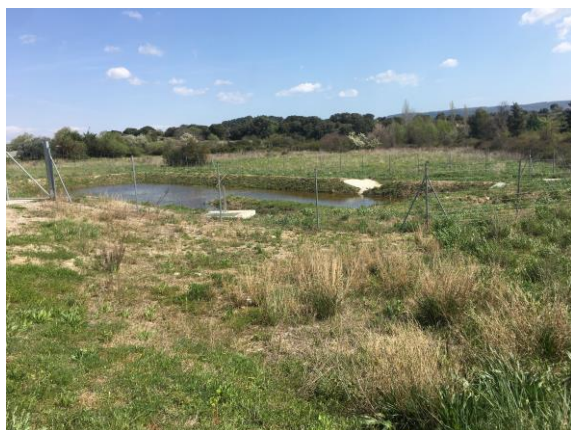
Bassins de rétention/infiltration sur la D5
