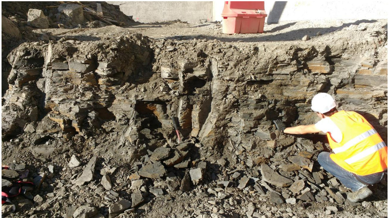
Fig. 5. Partie de coupe visible entre les cotes 234 et 237. Marnes feuilletées grises
