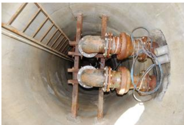
Photo 2 : intérieur de l'ouvrage et colonne d'exhaure des 2 pompes
