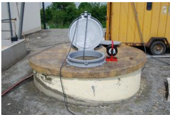
Photo 1 : puits de captage et repère de mesure
