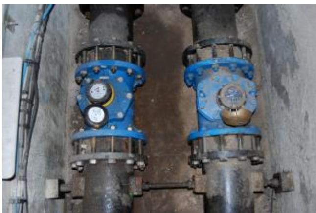
Photo 3 : compteurs volumétriques sur les deux conduites
