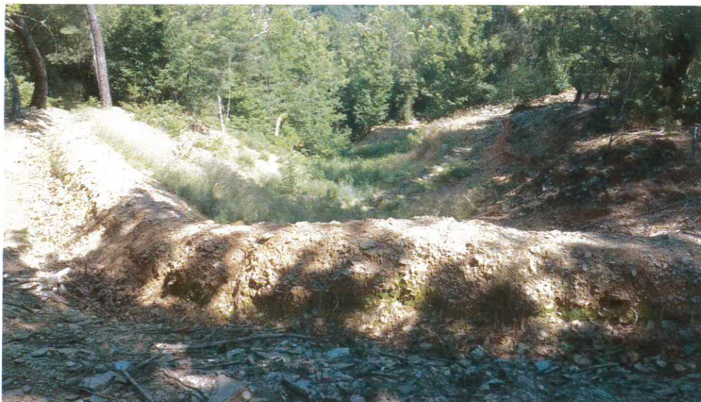
Planche photographique n°1 : vue de la tranchée de dérivation des eaux de ruissellement à l'amont du captage de Boisson et du thalweg d'implantation
