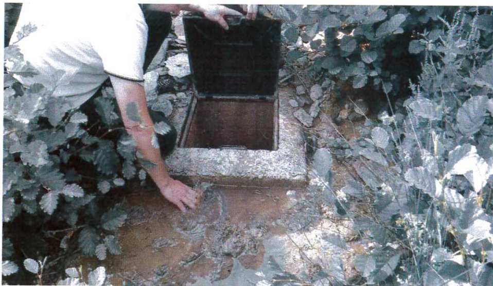
Figure n°10 : regard provisoire et ruissellement superficiel
