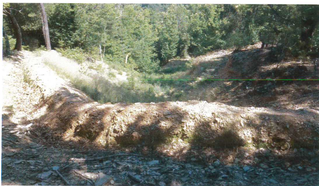
Figure n°9 : thalweg et fossé de dérivation des eaux superficielles
