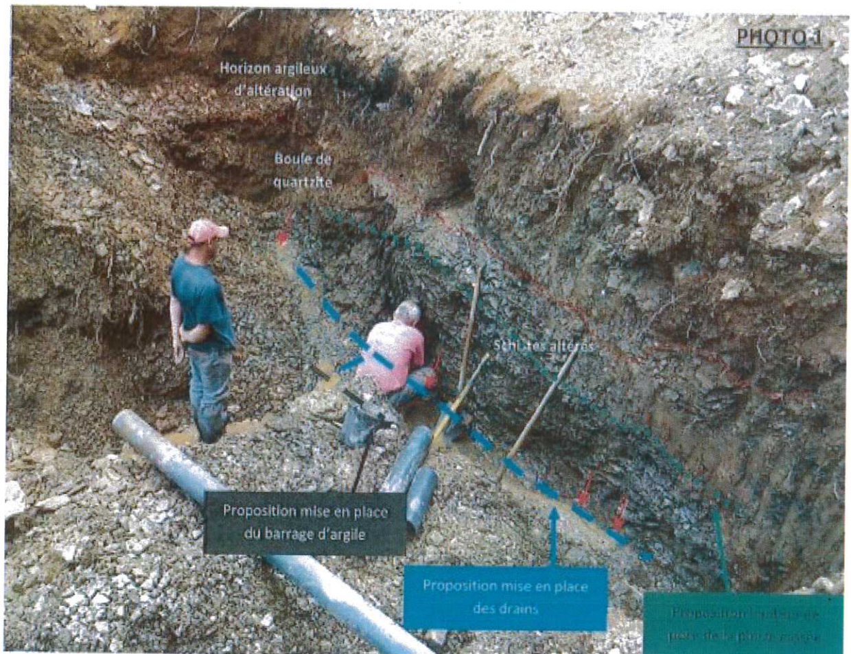
Figure n°5 : Vue du dégagement effectué au droit de la zone de captage
