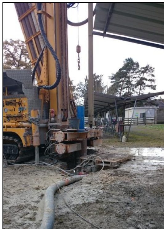
Photo 4 : Mise en place du tubage en PVC (rejet)
