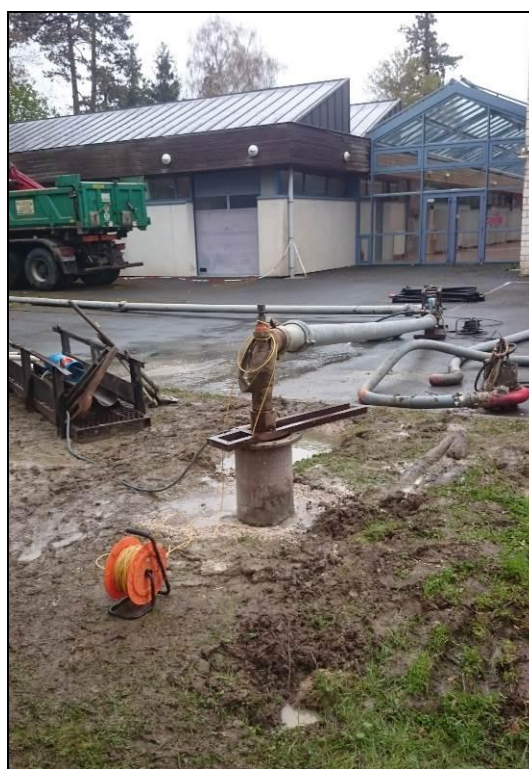
Photo 8 : Pompage-réinjection (ouvrage de pompage)
