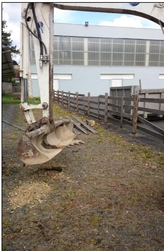
Photo 1 : Avant-trous à la pelle mécanique (rejet)
