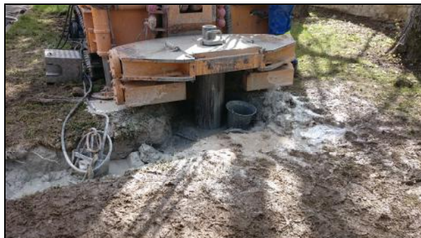
Photo 6 : Foration de la partie aquifère (forage de pompage)
