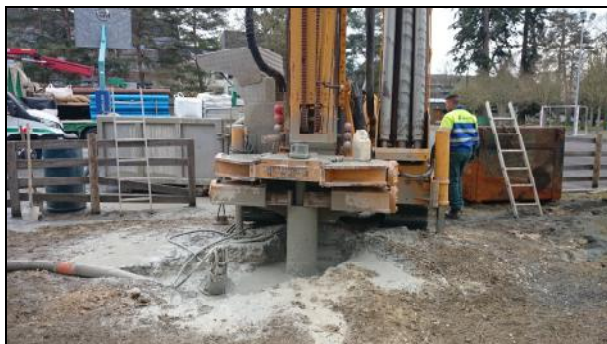
Photo 3 : Tubage en acier et foration de la partie aquifère (rejet)
