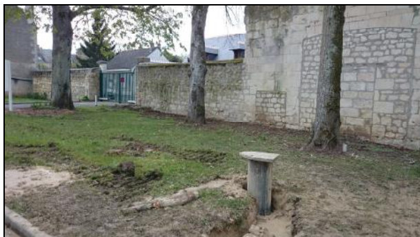
Photo 5 : Forage de pompage après cimentation des alluvions
