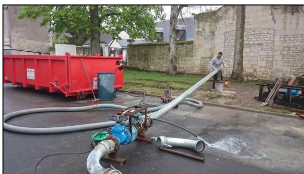
Photo 9 : Pompage-réinjection (ouvrage de pompage)
