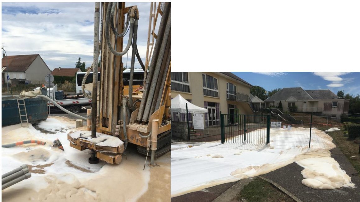
Figure 6 : Opération de récupération du fond de l'ouvrage
