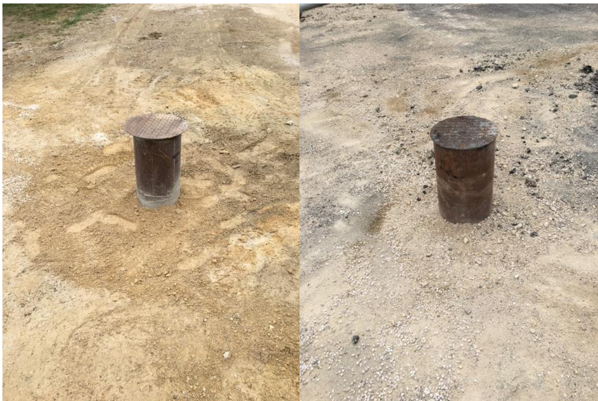
Figure 9 : Réception du chantier : forage de prélèvement à gauche, forage de réinjection à droite
