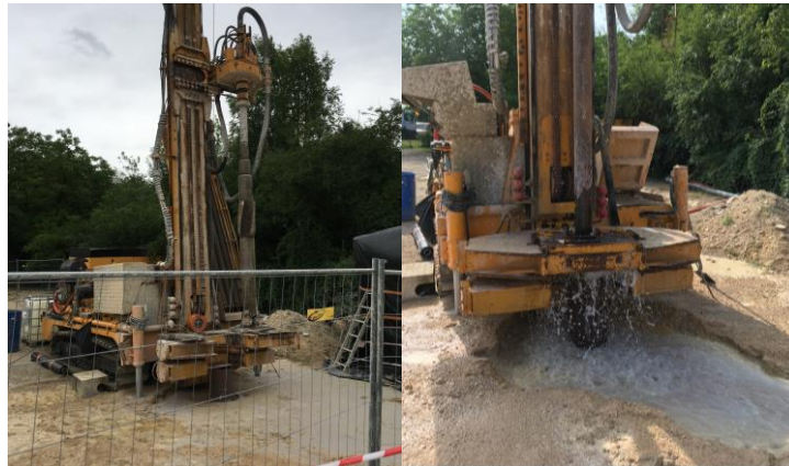
Figure 4 : Foration de la partie supérieure
