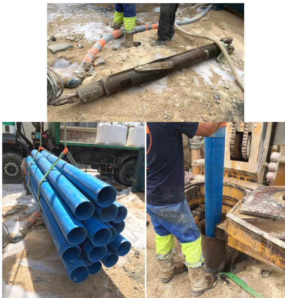
Figure 7 : Dépose de l'outil de foration et pose de l'équipement PVC
