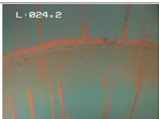
Photo 11 : Raccord entre les 2 tubes pleins en PVC 411/450 mm (1 tube de 3 ml et 1 tube de 1 ml avec fond plat).
