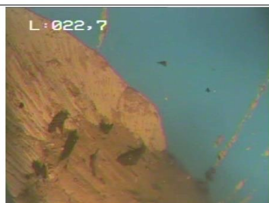
Photo 12 : Fond de l'ouvrage atteint à -22,90 m. Un monticule de sable est visible sur un côté du puits.
