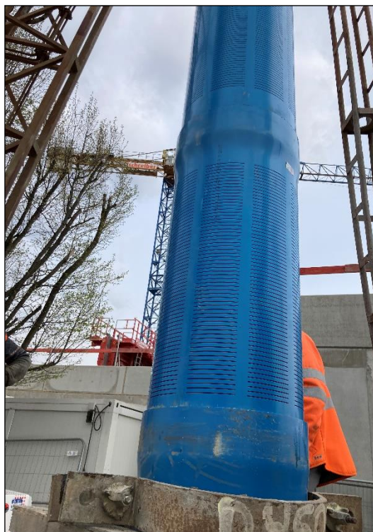
Figure 5 : Mise en place de la colonne en PVC 411/450 mm du puits de captage
