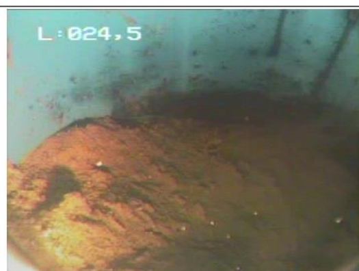
Photo 12 : Fond de l'ouvrage atteint à -24,7 m. Dépôt sableux d'environ 50 cm (Fond théorique à 25,2 m).
