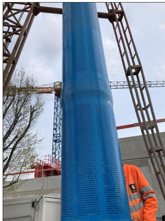
Figure 5 : Mise en place de la colonne en PVC 411/450 mm du puits de captage
