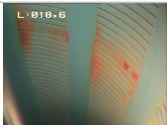
Photo 7 : Quelques traces d'oxydes métalliques sont visible sur la paroi en PVC 411/450 mm.
