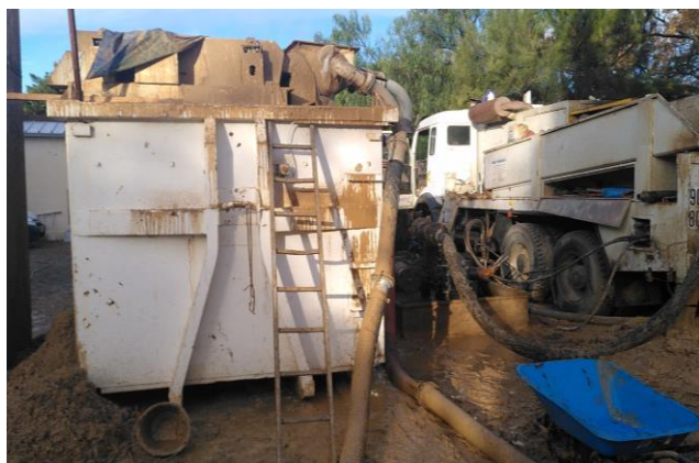
Bac à boues et pompe à injection (à droite)
