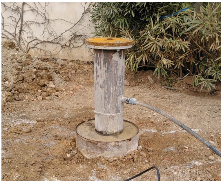
Forage terminé (sans dalle de protection)
