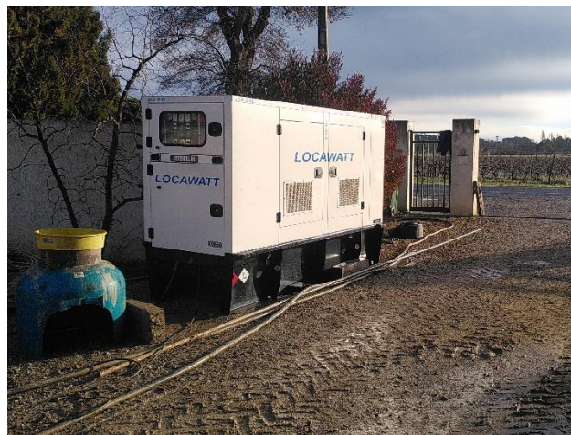
Groupe électrogène alimentant les pompes
