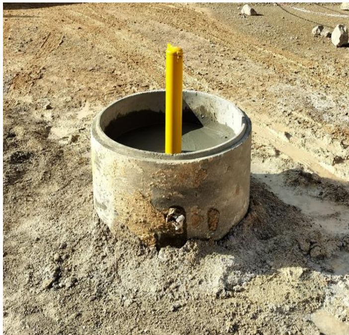
Figure 11 : Piézomètre P5 après la pose et la réalisation de la dalle béton
