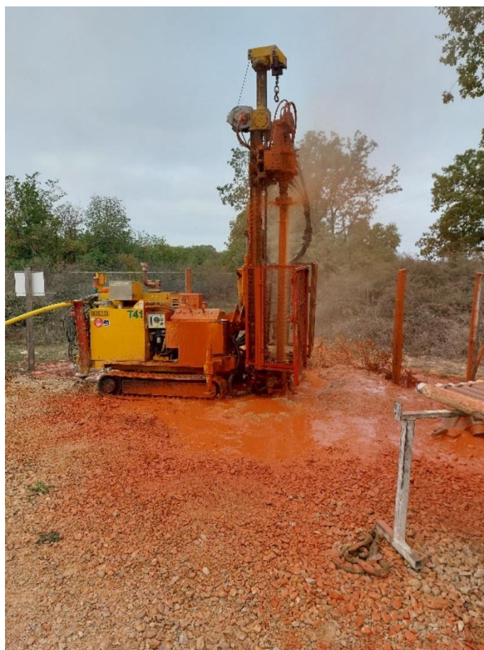
Figure 5 : Nettoyage à l'air du forage P4
