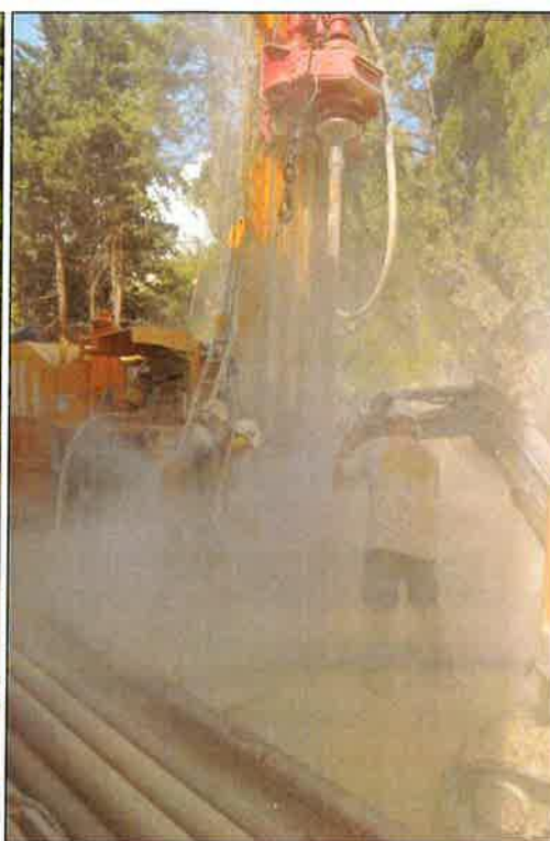
Photographie 2 : Foration au marteau
