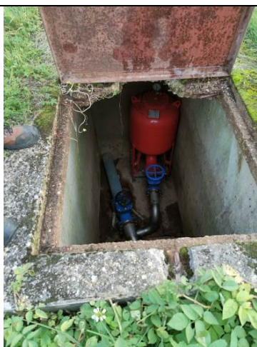
Photo 5 : chambre de visite du départ vers le réservoir du Château
