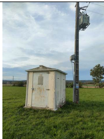
Photo 4 : Vue du transformateur sur le pylône à proximité du captage
