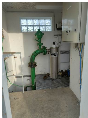
Photo 6 : chambre de traitement UV et départ vers le réservoir du Paradis
