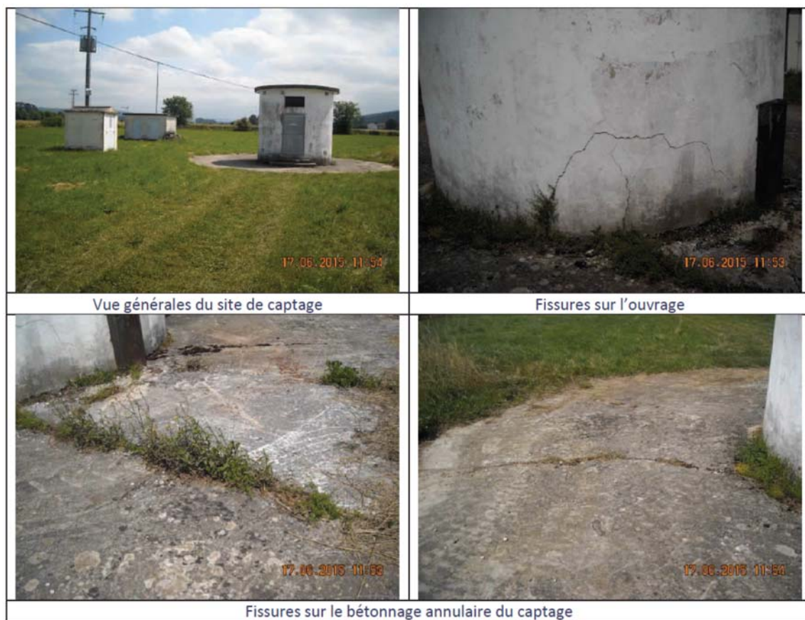
Photos 7 : vues du bâtiment de captage et de la dalle béton annulaire
