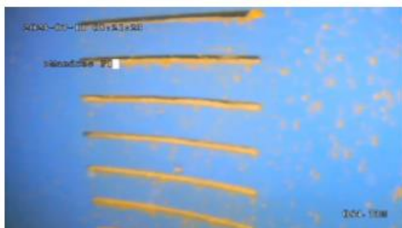
Vue radiale de la crépine PVC Ø 180 x 200mm – 64.73m
