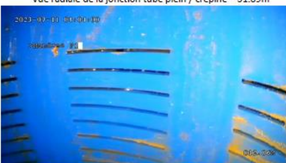
Vue radiale de la crépine PVC \varnothing 180 x 200mm – 32.06m
