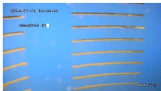
Vue radiale de la crépine PVC Ø 180 x 200mm – 66.33m
