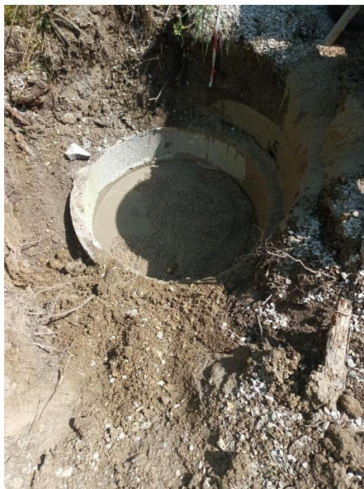
Puits non référencé fin cimentation
