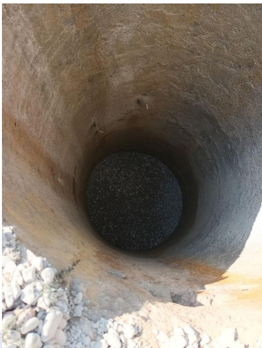
Puits BSS000WNCK fin gravillonnage
