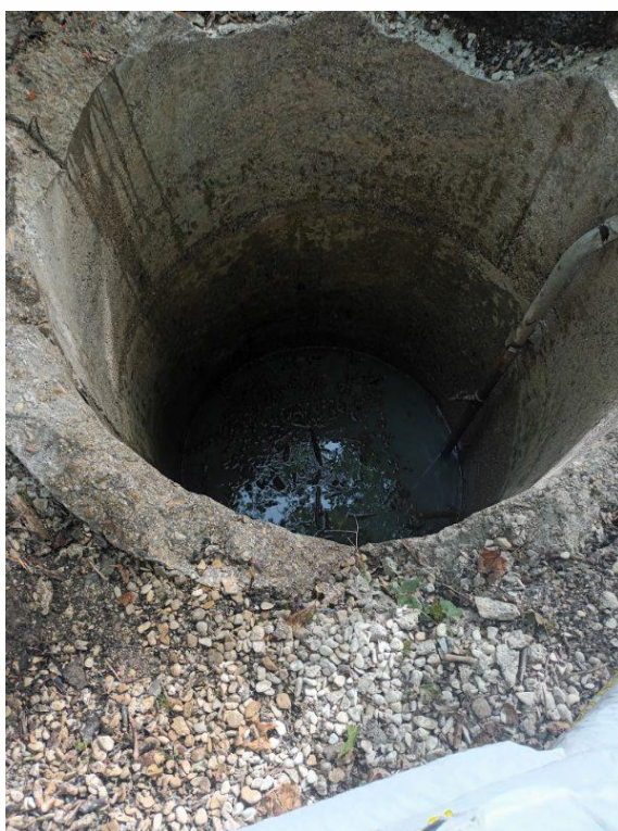
Puits avant comblement margelle enlevée
