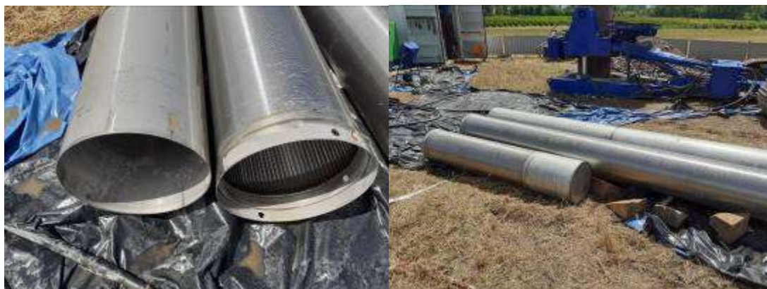
Figure 7 : Equipement en acier inoxydable DN400 AISI 304L à raccords manchonnés soudés
