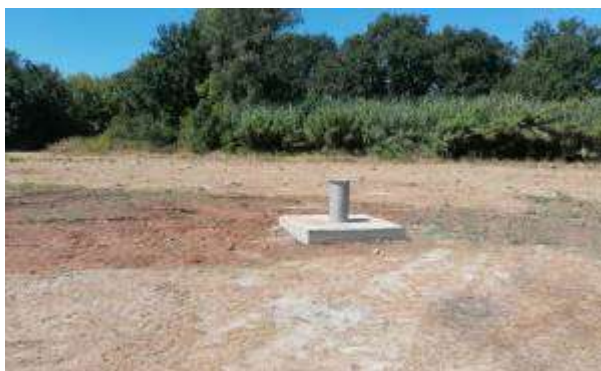
Figure 9 : Cimentation et réalisation de la margelle réglementaire
