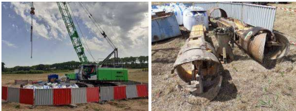
Figure 4 : Atelier de forage à la BENOTO / Benne preneuse
