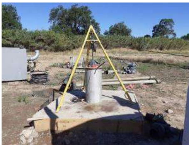
Figure 10 : Mise en place de la caméra pour l'inspection vidéo
