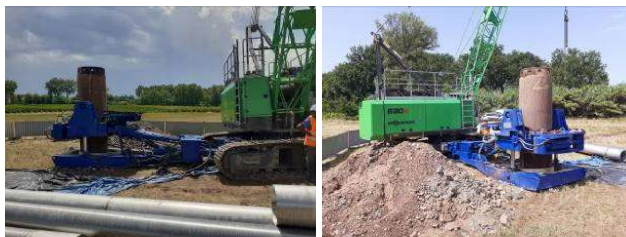
Figure 5 : Tubage de soutènement Ø 800 mm / Louvoyeur
