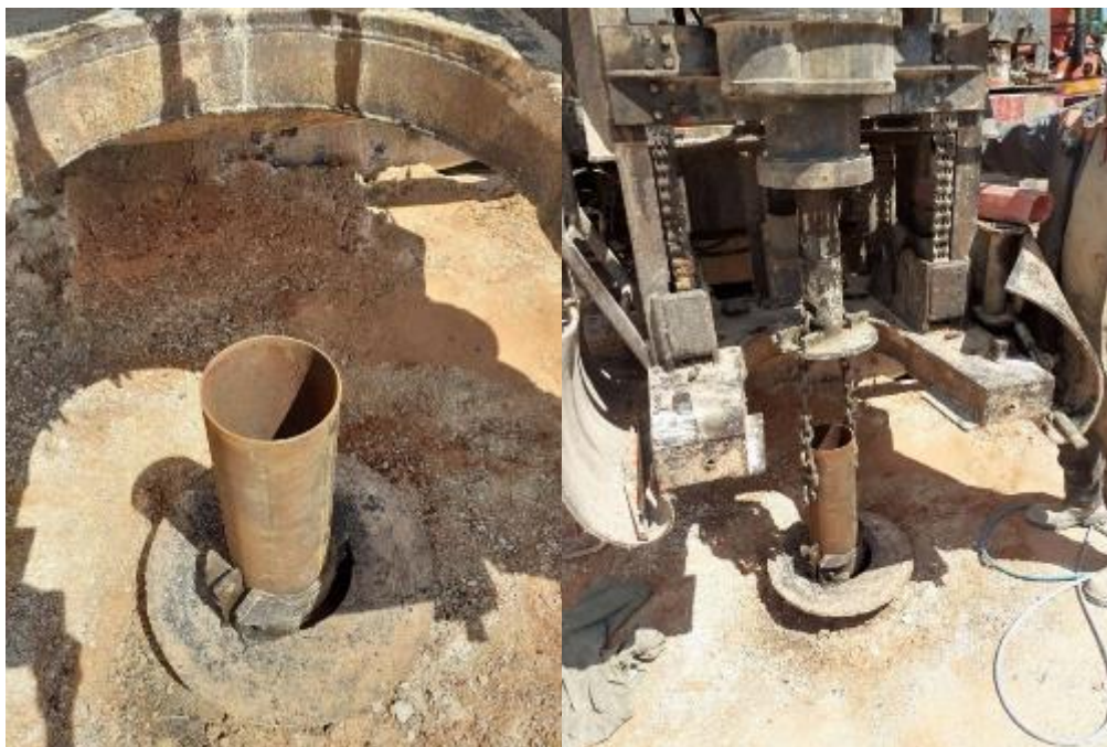
Figure 8 : Tubage provisoire en acier Ø139 mm
