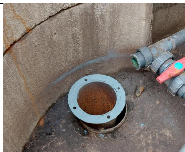
Tête de puits (sans pompe en place)
