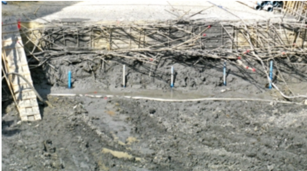
( Fig. 60c ) Affleurement du canal des Moulins à Mézières. Une dalle de béton armé est coulée sur la marne au fond du canal « des Moulins » (cf. n° 4 sur la Fig. 58).
