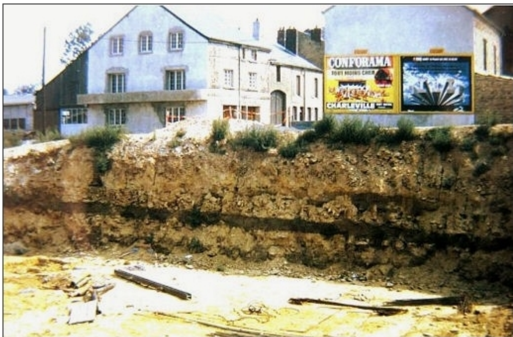
( Fig. 61 ) Affleurement de la Tranchée de la Rocade ouverte dans le Sinémurien inférieur. S'y observe une alternance de bancs de calcaires sableux avec inter-bancs de marne noirâtre, surmontés par 1,60 m de limons quaternaires déjà décapés. Un pont franchira la tranchée, raccordant la chaussée en direction du quartier de Mézières-Manchester (cf. n° 5 sur la Fig. 58).
