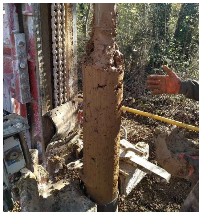
Gangue d'argile autour du marteau lors de sa sortie
