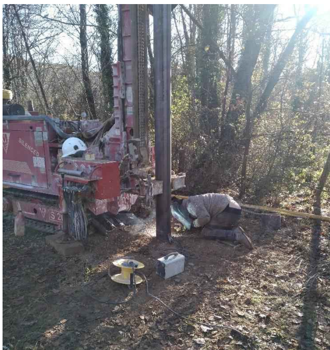
Soudure du tubage Ø 193 mm
