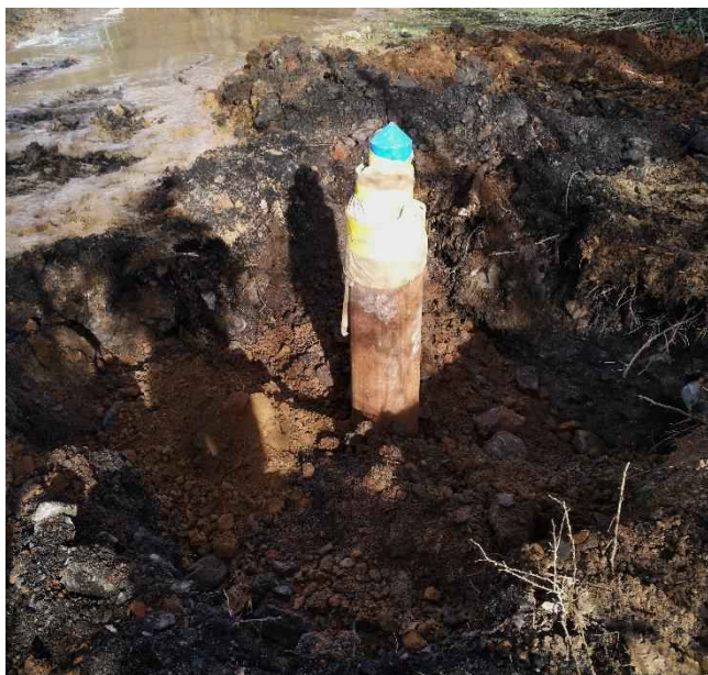
Remplissage de la fosse d'excavation à l'extrados du tubage provisoire Ø273 mm
