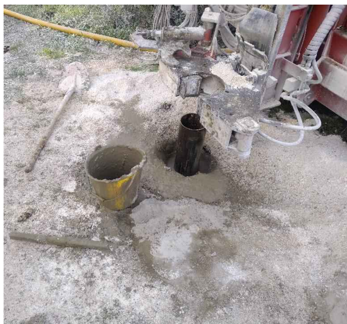
Cimentation du pré-tubage en cours
