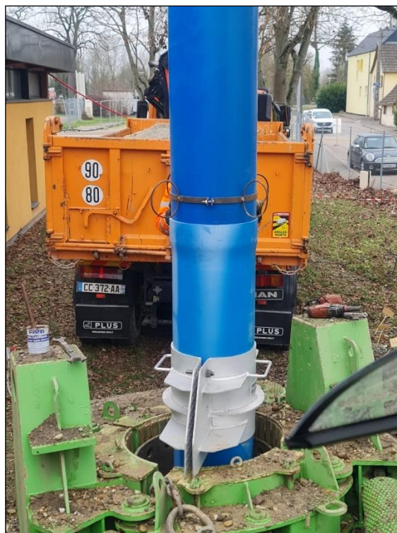
Figure 5 : Assemblage de la colonne en PVC 411/450 mm du puits de rejet
