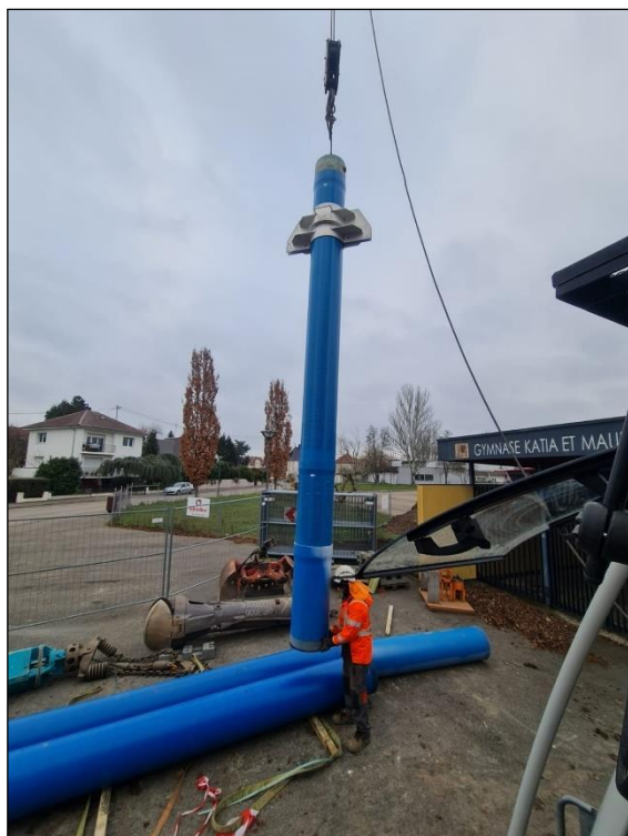
Figure 5 : Assemblage de la colonne en PVC 411/450 mm du puits de rejet
