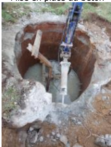
Démontage de la tête d'ouvrage
