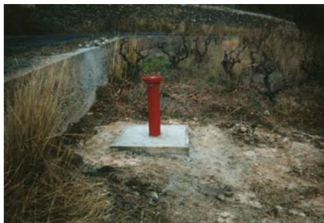
*Illustration 1 - Tête de puits du piézomètre d'Estagel (66).*
