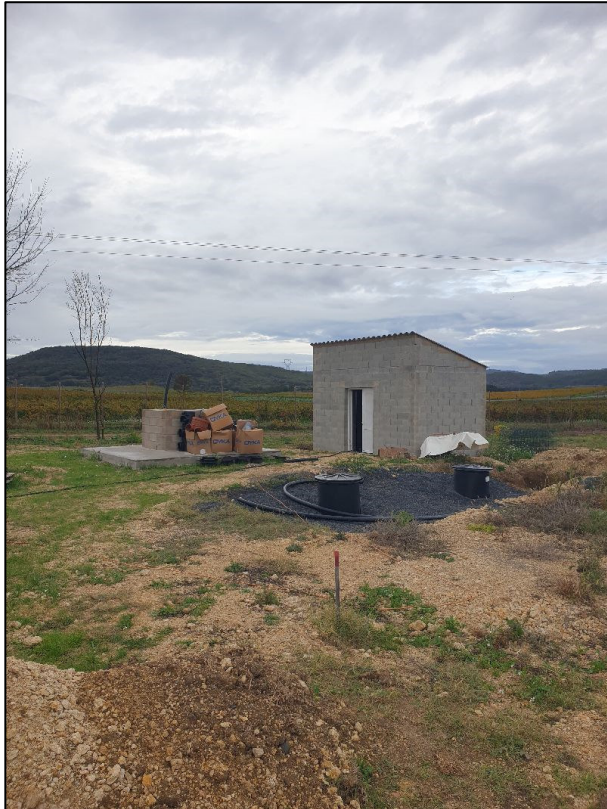
Figure 5. Photographie montrant la cuve de 20 m 3 enterrée (1 er plan), le local technique (droite de l'image) et le forage (gauche de l'image)
