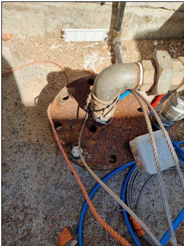
Figure 11. Photographie de la tête de forage F1
