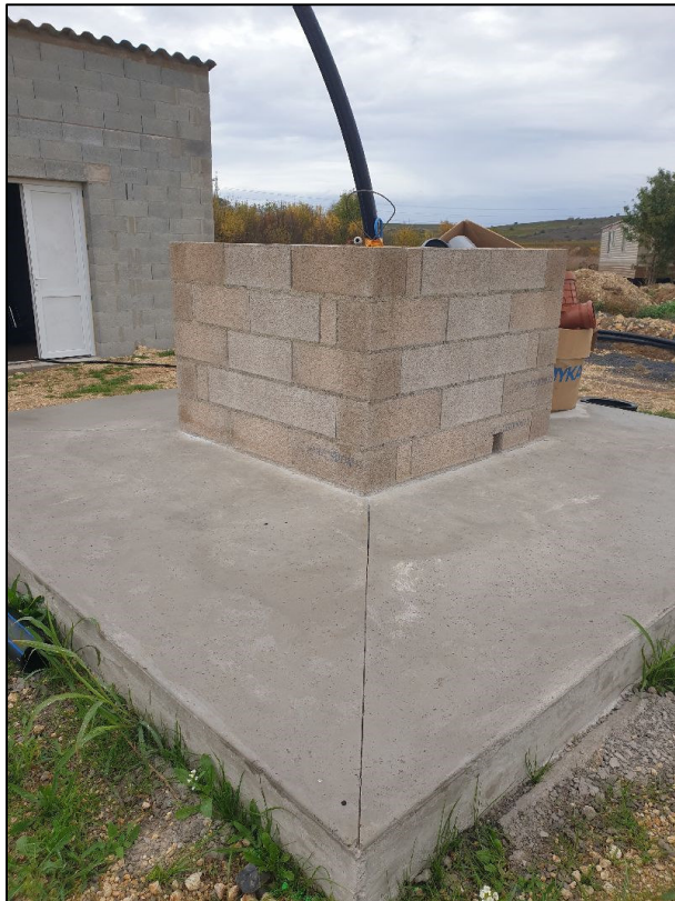
Figure 3. Photographie de la dalle béton aménagée autour du forage
