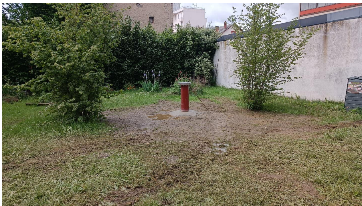
Figure 1 : tête de puits en fin de chantier
